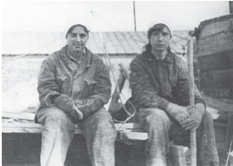
◀ Перерыв при загрузке бетономешалки. Надя Шуйская, Валя Рябчикова, ССО «Мелори-2», 1978 г.
