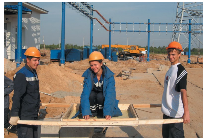
▲ Бойцы пермских строительных отрядов, 2008 г.
