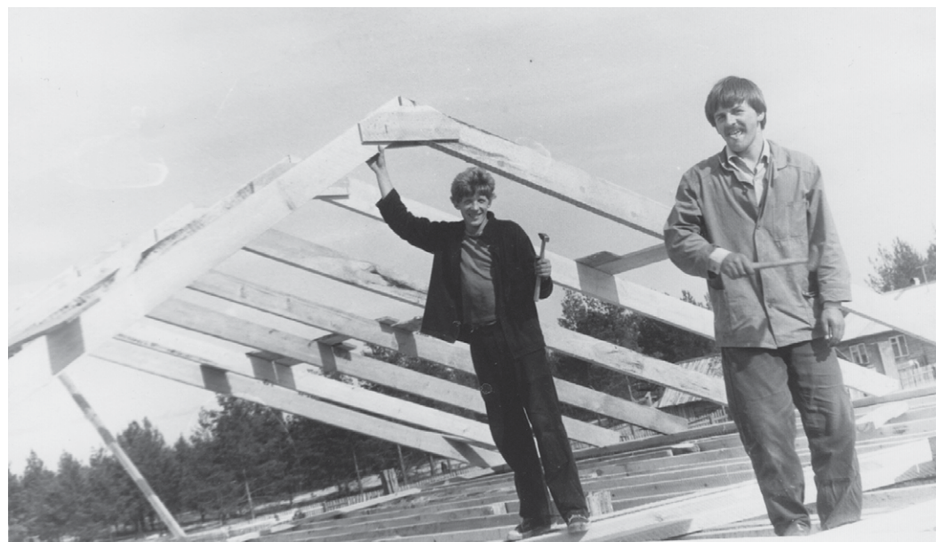
◀ Работа в строительном отряде.
