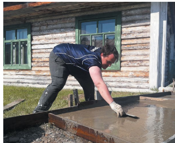
◀ СВО «Пермские медведи». Заливка бетон- ных дорожек в музее «Пермь-36».
