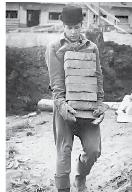
Боец отряда В.П. Гуляев. Отряд «Строитель» ППИ, д. Большой Талмаз Куединского района, 1967 г. Из архива В.П. Гуляева.
